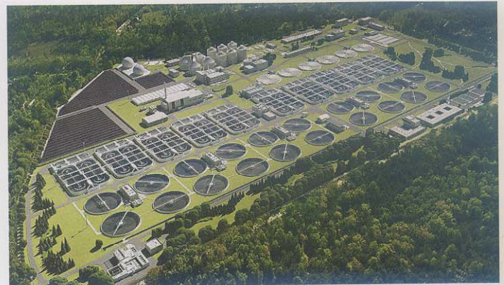
Czajka – nach Fertigstellung die größte Kläranlage Polens, im Endausbau mit 37 Brandmelderzentralen IQ8Control.
